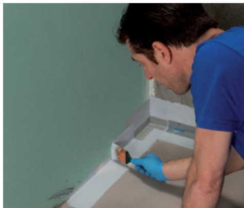
Aanbrengen van Mapeband PE 120 met Mapegum WPS
