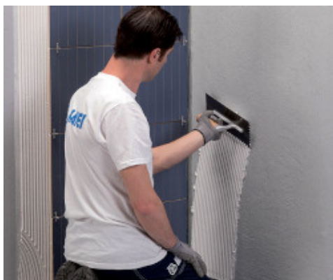
Aanbrengen van wandbekleding met Keraflex Maxi SI Zero
