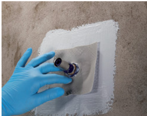
Aanbrengen van een Mapeband PE 120 afdichting voor doorlopende gaten met Mapegum WPS
