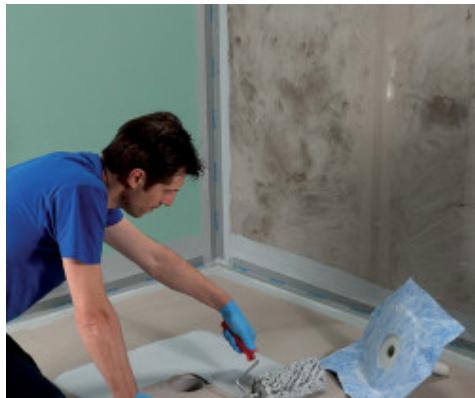
Aanbrengen van een verticale afvoerput met Mapegum WPS
