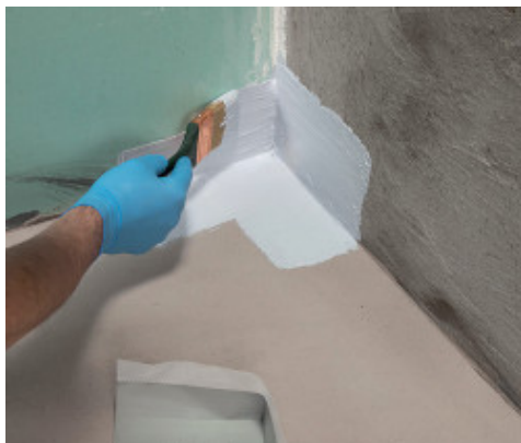
Aanbrengen van een 90° Mapeband PE 120 hoekstuk met Mapegum WPS
