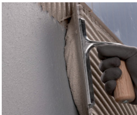
Aanbrengen van vloerbedekking met Ultramastic 5
