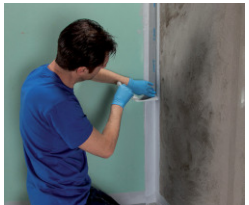
Aanbrengen van Mapeband PE 120 met Mapegum WPS
