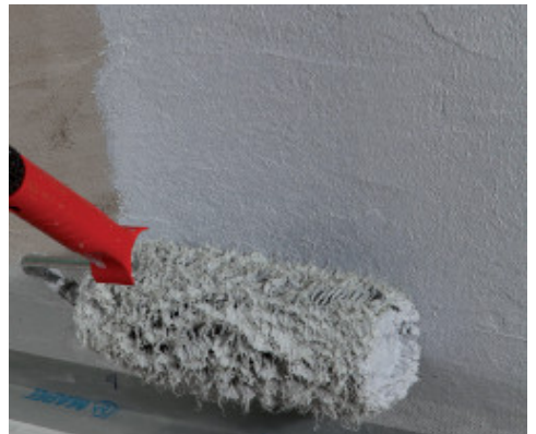
Aanbrengen van Mapegum WPS met een roller
