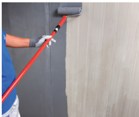
Met een roller aanbrengen van Eco Prim Grip Plus op beton
