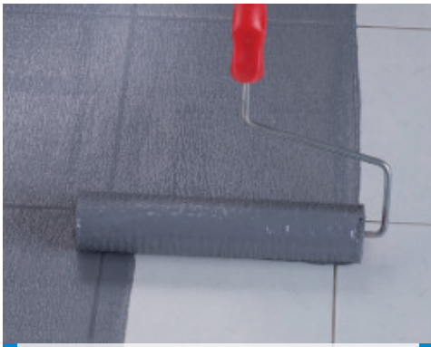
Met een roller aanbrengen van Eco Prim Grip Plus op bestaande porseleinen tegels
